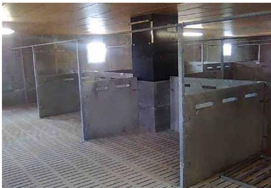
La séparation se fixe au mur et sur des poteaux galva, surmontés d'un tube qui traverse la salle de part en part. Existe en hauteur 117 ou 107.
