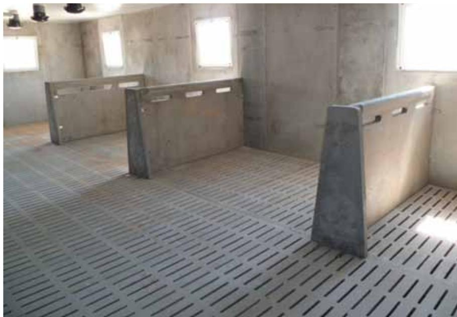
La séparation se fixe au mur et sur une plaque de fixation triangulaire spécifique. L'ensemble est maintenu par des équerres inox. Existe en hauteur 117 ou 107.
